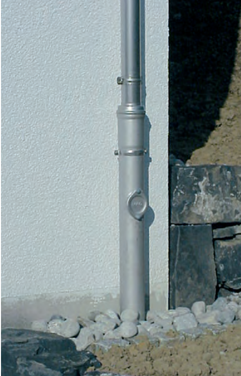
Standrohr mit Reinigungsöffnung
