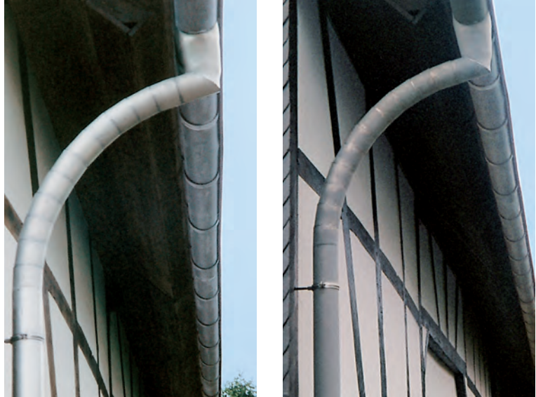
Patinaentwicklung auf einem verzinnten nicht-rostenden Stahl: links neu, rechts nach etwa zweijähriger Bewitterung
