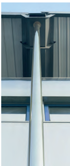
Regenfallrohre aus hochglanzpoliertem nichtrostendem Stahl an einem Gewerbeobjekt in Gavá
